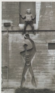
À droite. Empreinte du Modulor dans le béton, Unité d'habitation, 1952. Rue Théodore Brossaud, Rezé-les-Nantes. Photo service de presse. © FLC, ADAGP, Paris 2015 © J.Ach
